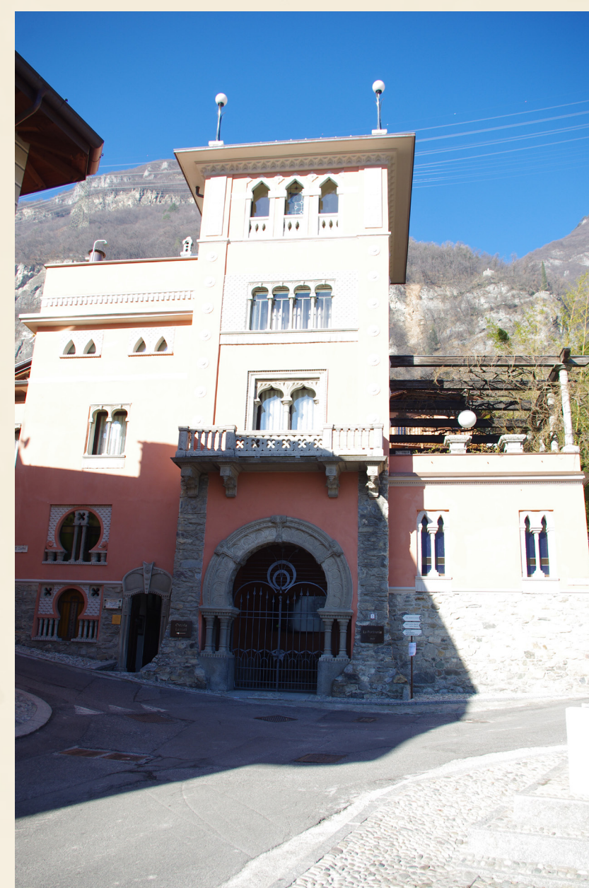
Torre d'entrata (portineria) alla proprietà Gheza com'è adesso
