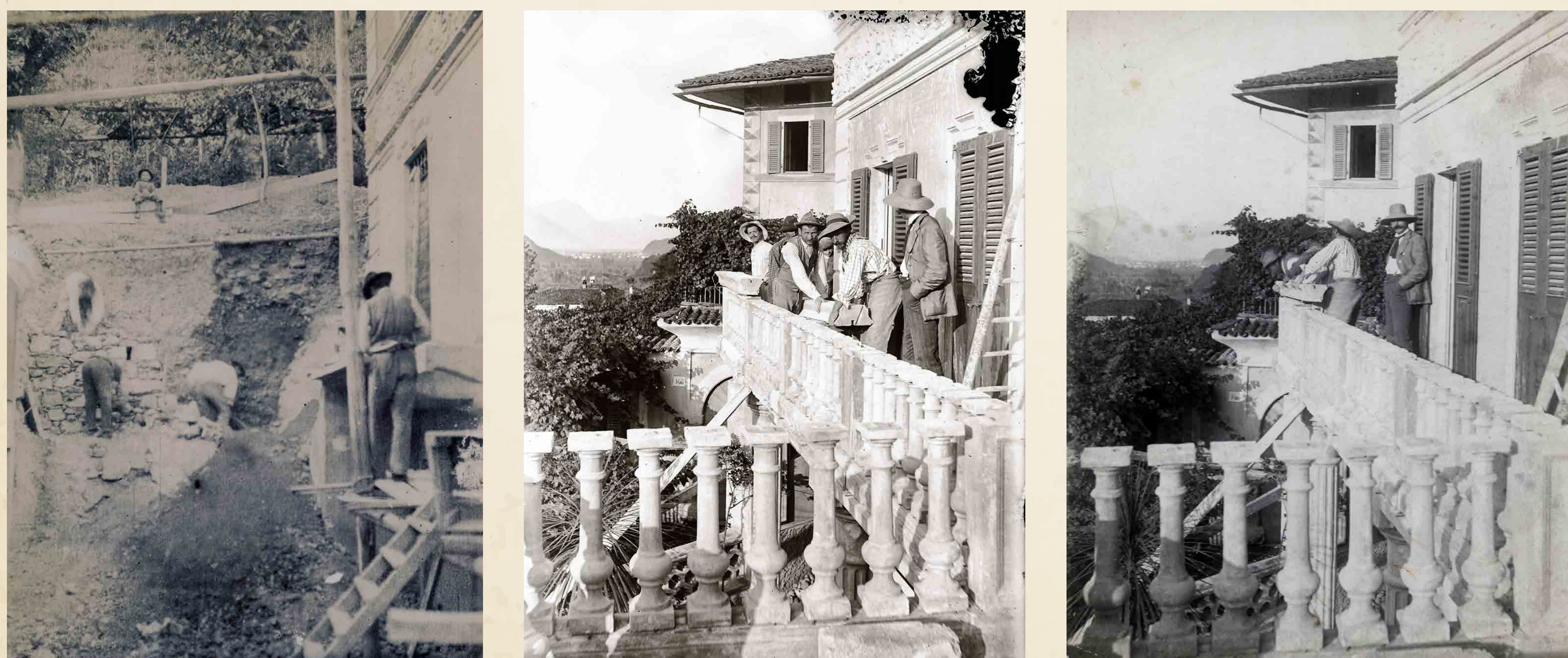
Lavori di restauro della villa Lanzata (1906-1908)
