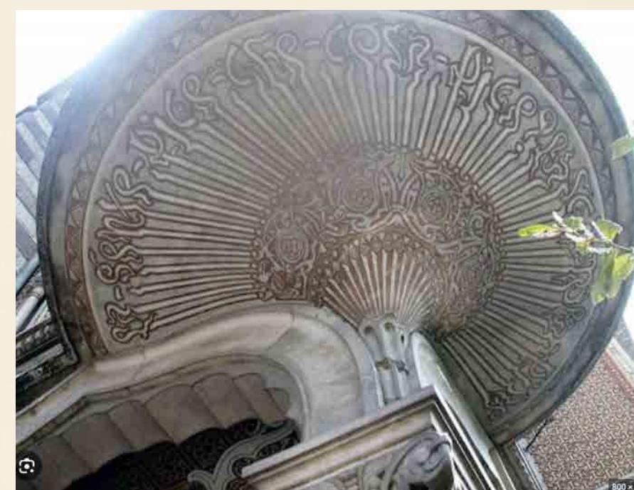
Parte sottostante del terrazzo (fonte Internet)
