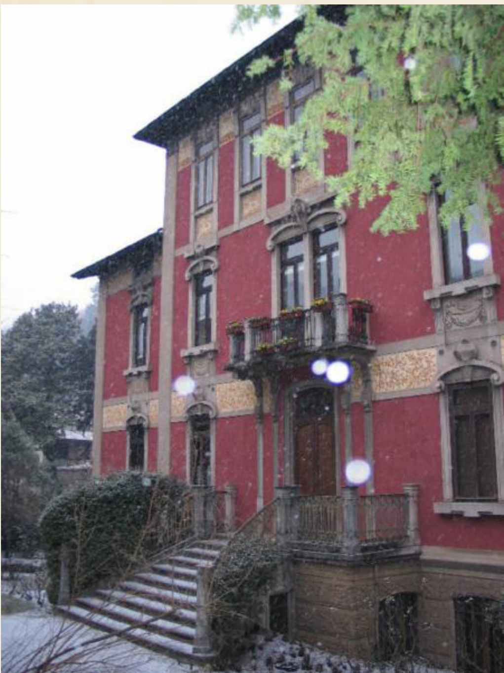
Villa De Michelis: qui Pietro, dopo la sua costruzione avvenuta nel 1910, abitava al secondo piano e aveva lo studio al piano terra
