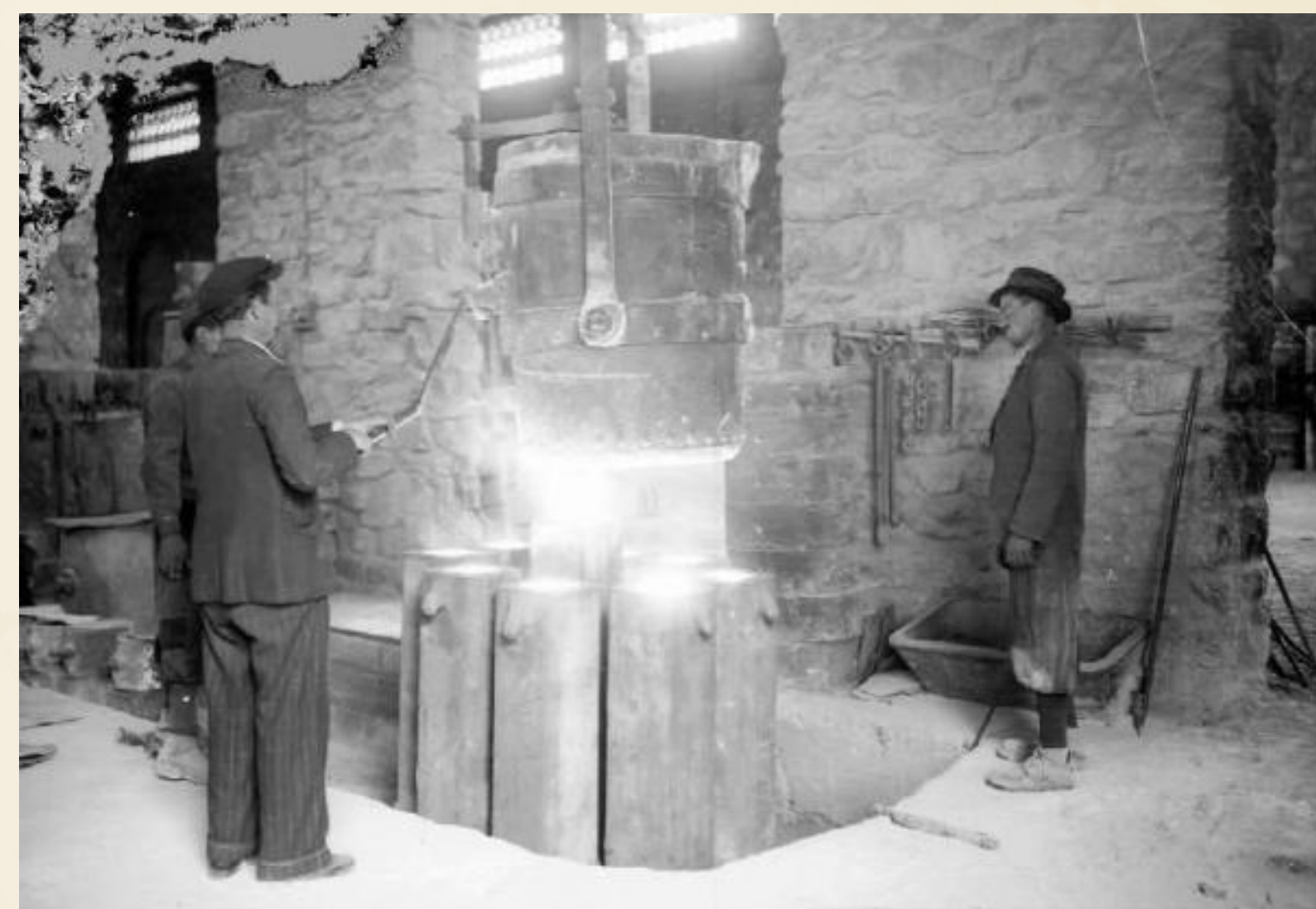
Siviera: recipiente per il trasporto della colata negli stampi (foto Magnolini)
