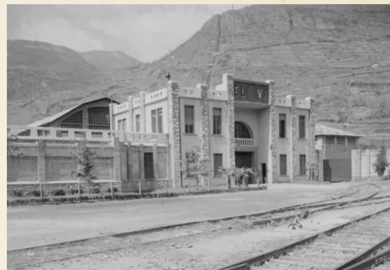
Palazzina Uffici ed entrata della SELVA (foto Magnolini)
