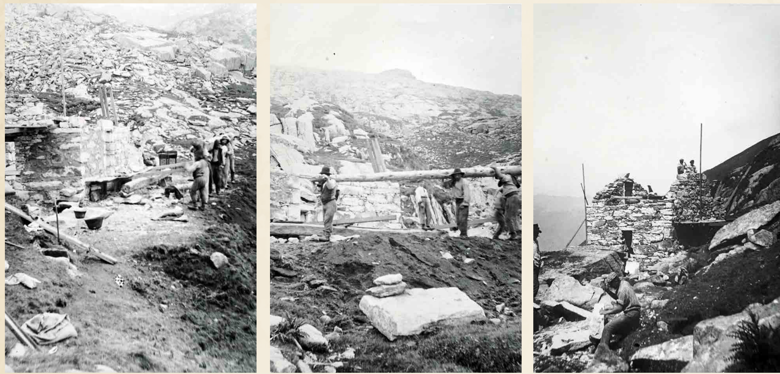
Lavori per la costruzione del rifugio Foppe di Braone (1909)
