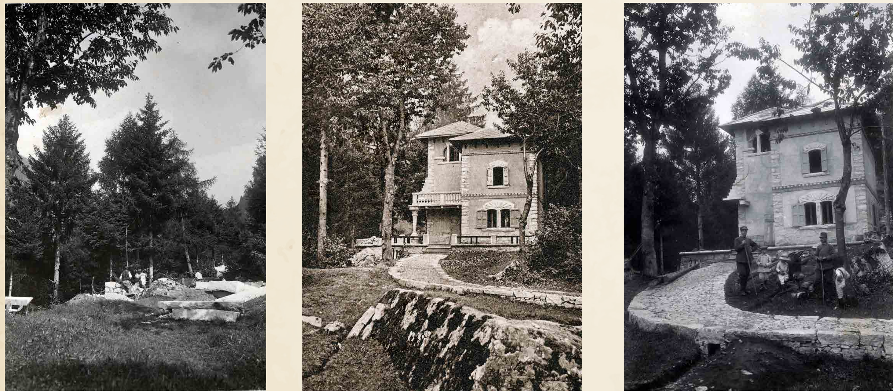
Inizio lavori casa di Piazze Casa di Piazze ultimata (1915) Casa di Piazze nel 1917
